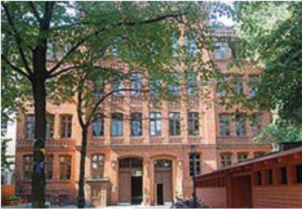
Obr. č. 7 Budova školky Kita im Tam.
