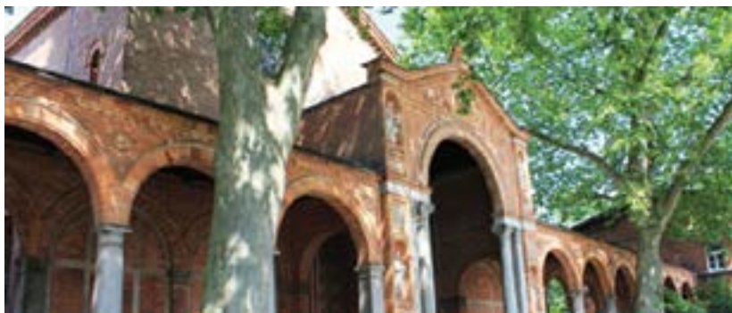
Obr. č. 2 Evangelický kostel St. Johannes, u kterého sídlí školka Kita St. Johannes.
